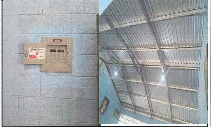
Foto 2: Instalación de energía eléctrica en las aulas finalizado
