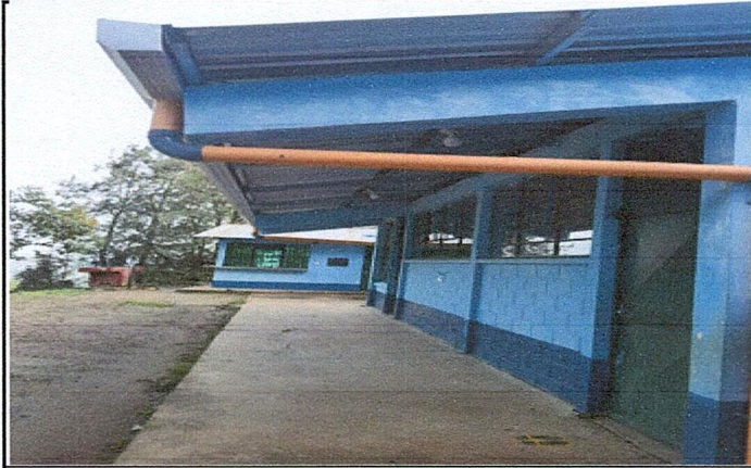
Foto 1: Mejoramiento del techo frontal finalizado
