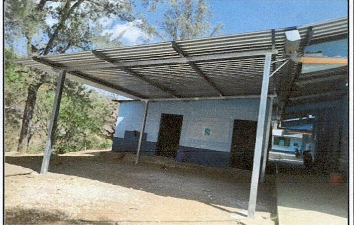
Foto 4: Mejoramiento de la galera de una cocina finalizado
